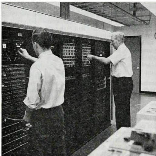
Tableau de contrôle central des systèmes de transmission commandés par ordinateur au Central des données des Télécommunications du CN à Toronto, dont le rôle principal est de s'occuper des réservations d'Air Canada et des Chemins de fer Nationaux. La Direction de la météorologie du ministère des Transports utilise aussi les systèmes pour transmettre dans tout le Canada les cartes météorologiques donnant les derniers pronostics.
